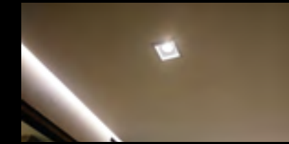
Faux plafond suspendu avec éclairages intégrés orientables
