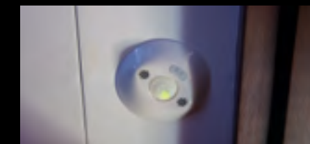
Éclairage automatique connecté à un détecteur de mouvement
