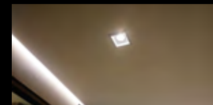
Faux plafond suspendu avec éclairages intégrés orientables
